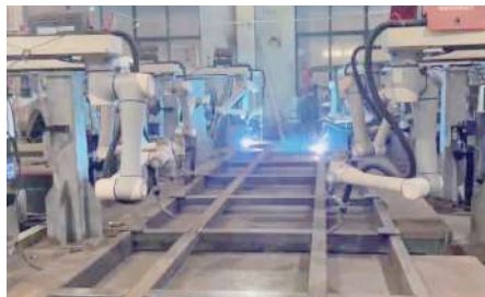
Soldagem de Estruturas de Aço
