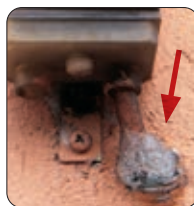
Protecção da entrada do tubo corrugado
