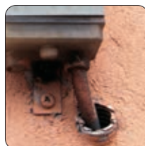
Protecção da entrada do tubo corrugado
