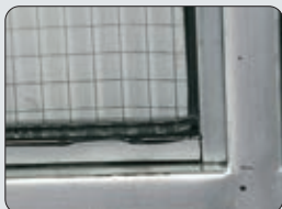
Selagem de vidros
