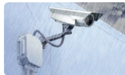
Instalação com cabos livres.
